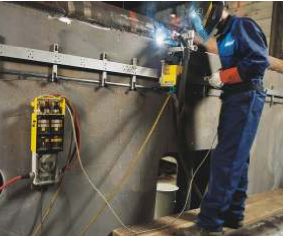
Soldagem MIG/MAG: diversas possibilidades de mecanização.
